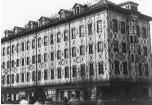
Le "moulin Saulnier" à Noisiel (Seine et Marne), l'un des premiers bâtiments du monde à structure portante métallique (1874).
