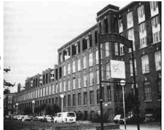
L'usine LeBlan à Lille, filature de lin reconvertie en appartements. Comme ci dessus, les fausses tours abritent les escaliers.
